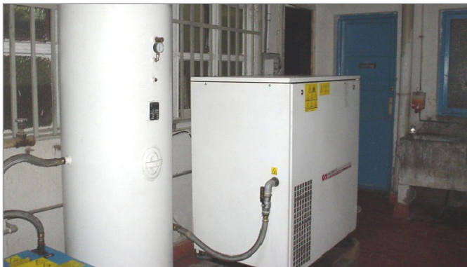
F.6 Air compressor
